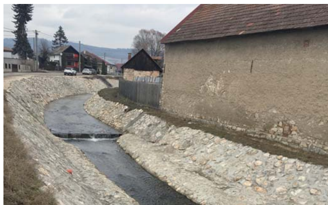
Spevnený úsek koryta potoka Margecianka.
