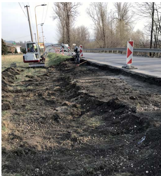
Práce na cyklochodníku prebiehali v apríli tohto roku.
