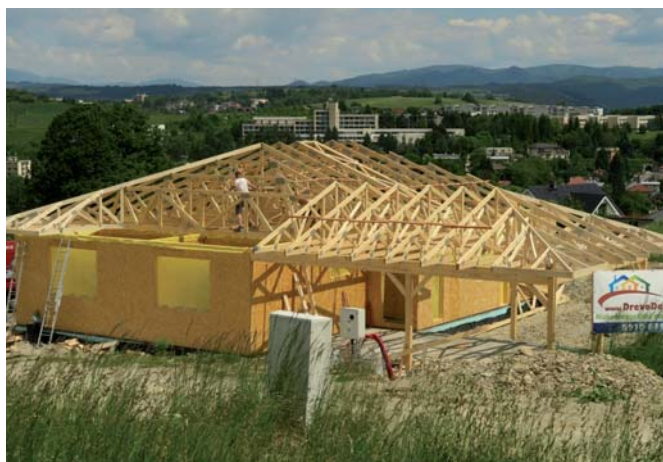
Realizácia montovaného nízkoenergetického domu v Banskej Bystrici.
