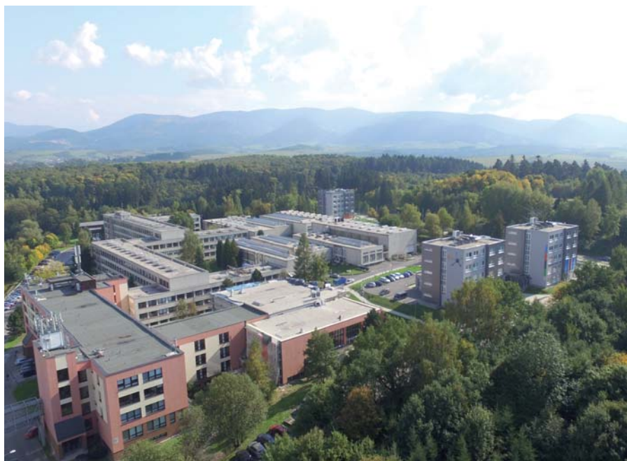
Budovy Univerziténeho vedeckého parku sú na fotografii úplne vpravo.
