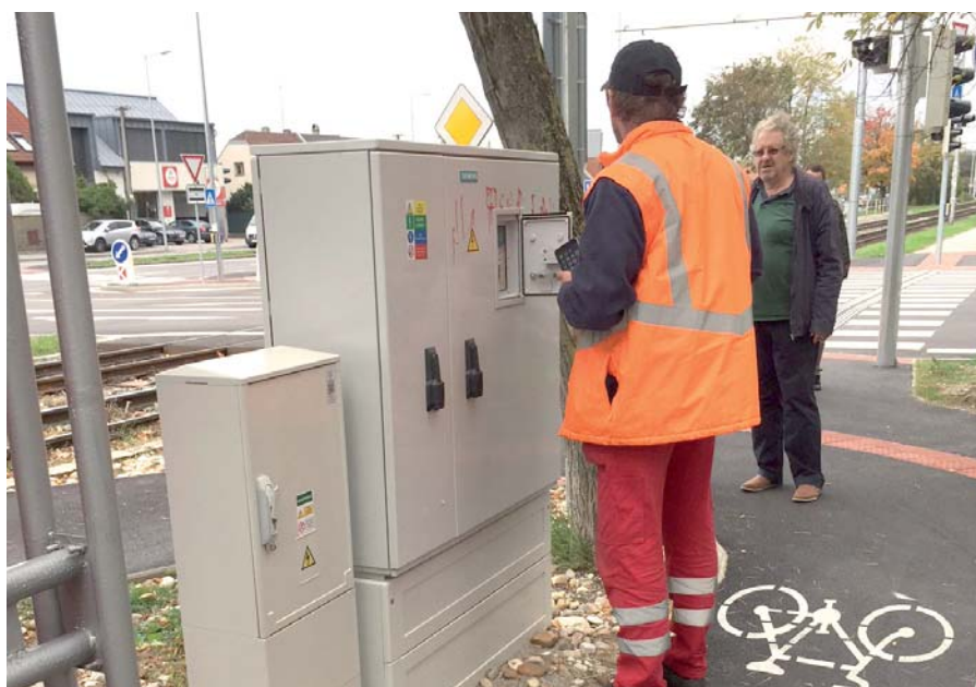
Informačné tabule na zastávkach sú pripojené na zdroj energie.
