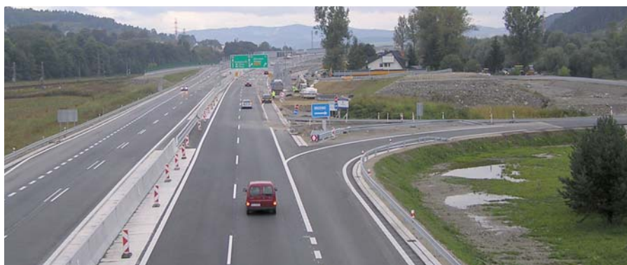
Z tunela Považský Chlmec sa novootvorený diaľničný úsek napája na cestu smerujúcu do Kysuckého Nového Mesta.
