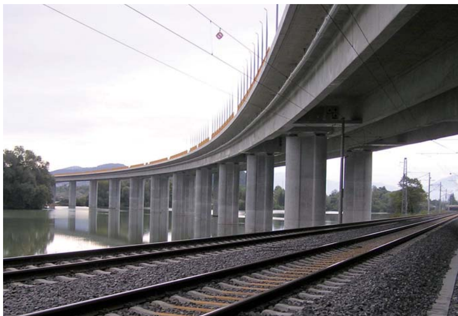
Diaľničný obchvat Žiliny v úseku Strážov - Brodno je unikátny svojou konštrukciou, vedie ponad Hričovskú priehradu, potom cez tunel v Považskom Chlmci. Stavajú ho s pomocou prostriedkov z EÚ.
