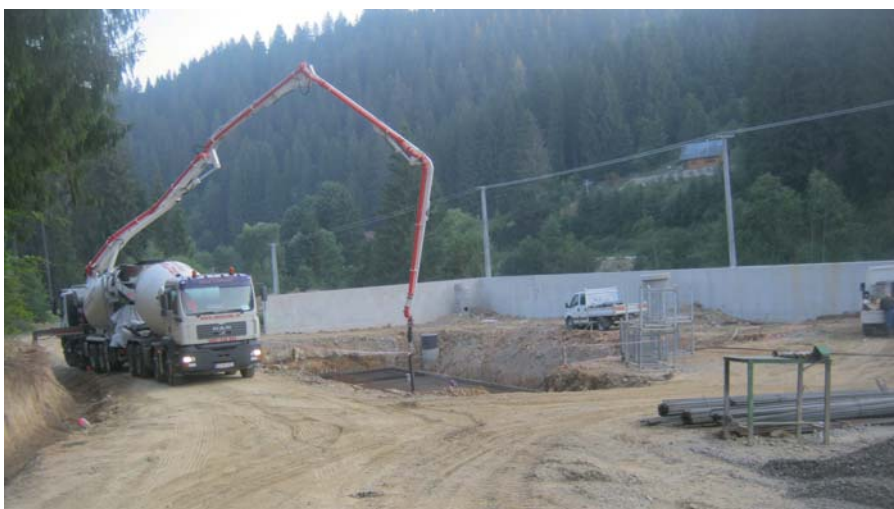
V rámci projektu stavajú aj novú generálnu čistiareň odpadových vôd.
