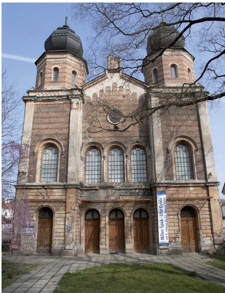
Vzácná pamiatka - Synagóga v Trnave, prešla rozsiahlou rekonštrukciou.
