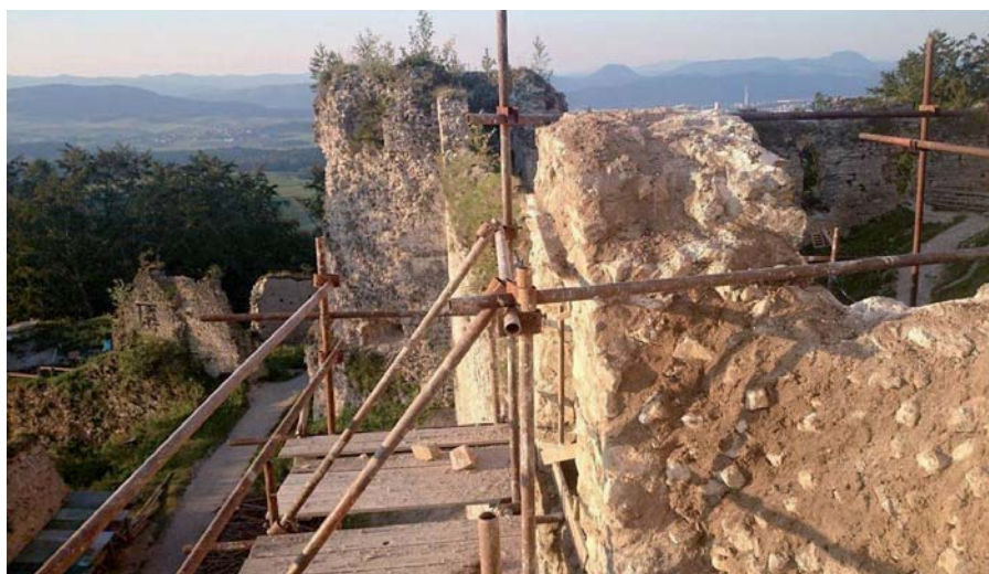
Strielňa po domurovaní a výhľad na široké okolie.
