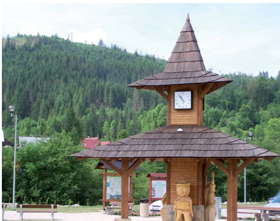
Tradičná kysucká šikmá šindľová strecha je typická pre centrum Novej Bystrice.
