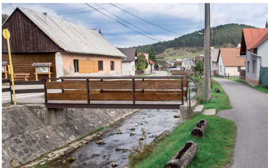
Zrekonštruované lávky cez potok.
